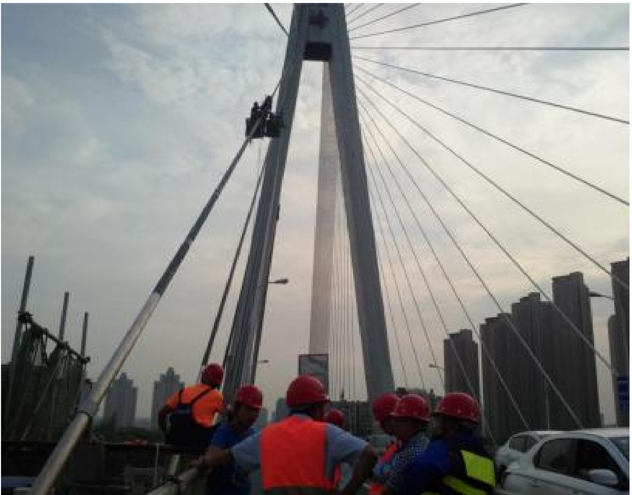
桥梁悬索钢丝绳无损检测现场
