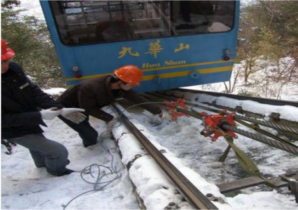
索道缆车钢丝绳无损检测现场
